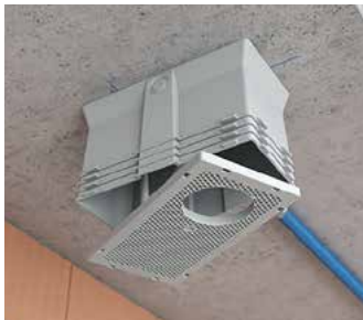
Platine avant à clipser
