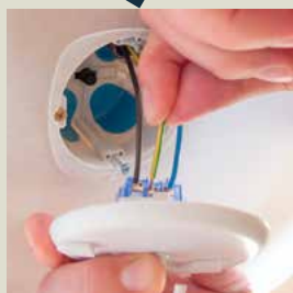
Volume important et câblage aisé de la terre
