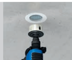
Couvercle à percer en fibre minérale
