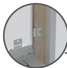
Fixation du châssis par pattes
