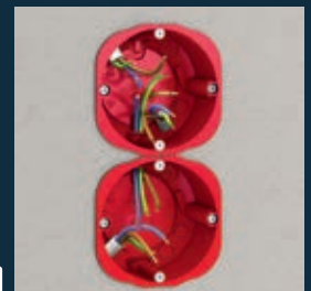
Cablage continu grâce aux tubulures de jonction
