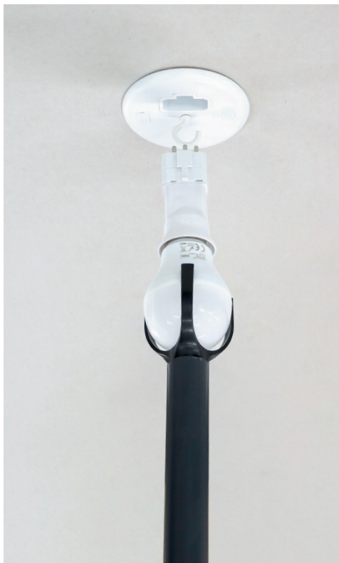
4 Présenter ensuite la lampe à l'aide de la CANADOUILLE LED face au socle DCL pour l'encliquetage de la fiche-douille
