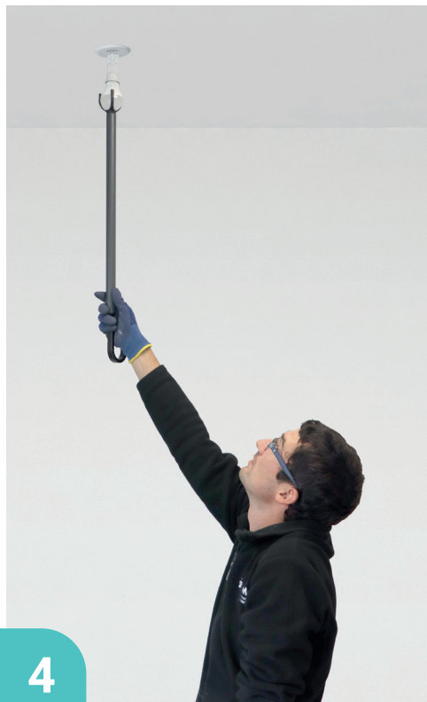
4 Présenter ensuite la lampe à l'aide de la CANADOUILLE LED face au socle DCL pour l'encliquetage de la fiche-douille
