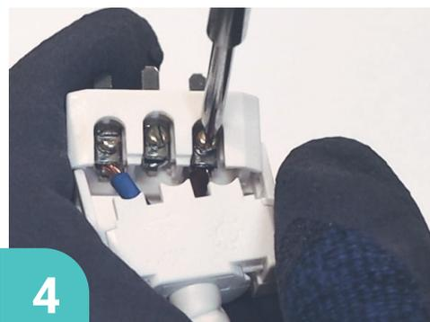
4 Fixer le neutre et la phase à l'aide d'un tournevis
